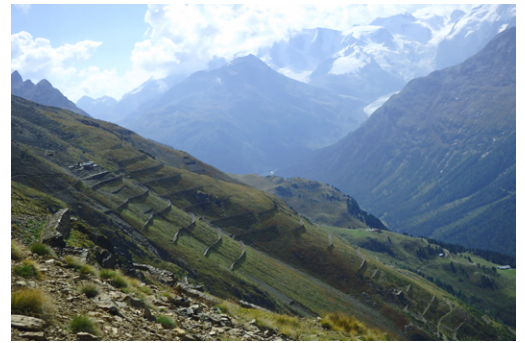
Blick über die Steinlawinerverbauung ob Pontresina
